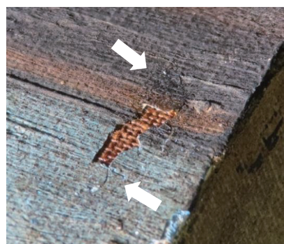
圖 26 加固起翹顏料後
