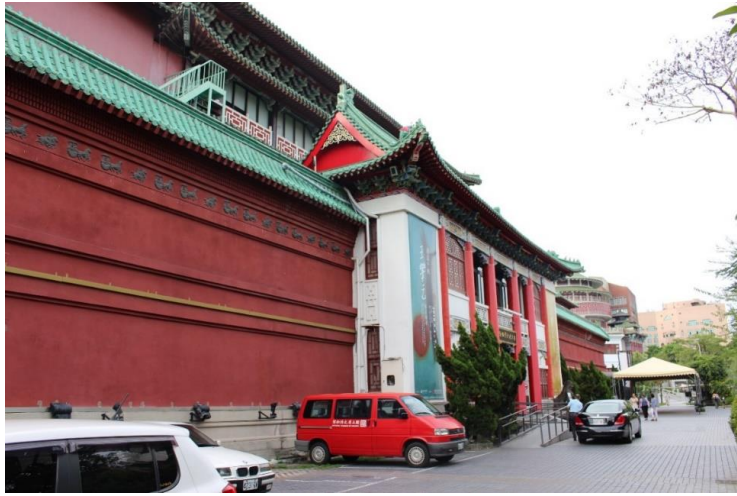
圖 5 2018 年的史博館，可見左側四樓增建的鐵皮辦公室、四樓迴廊加建及附掛鋼梯與管線情形。圖片來源：國立歷史博物館。
